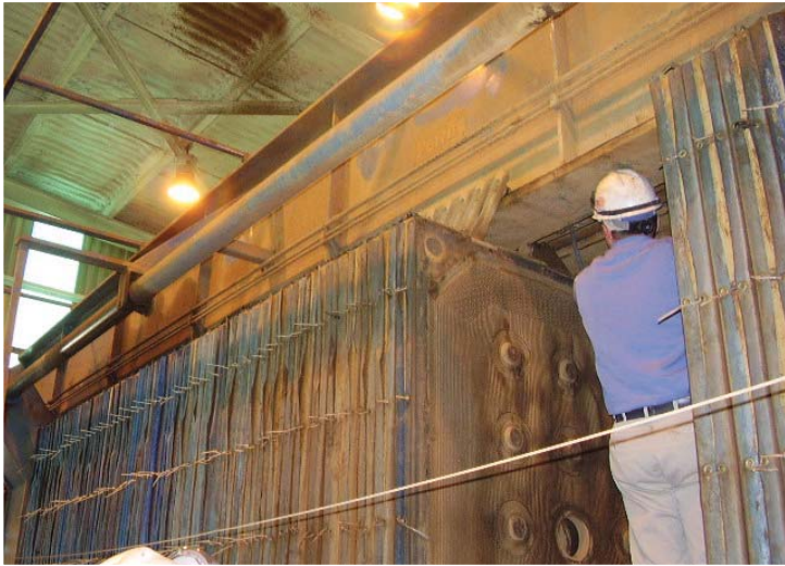
Revisiones técnicas de las instalaciones
